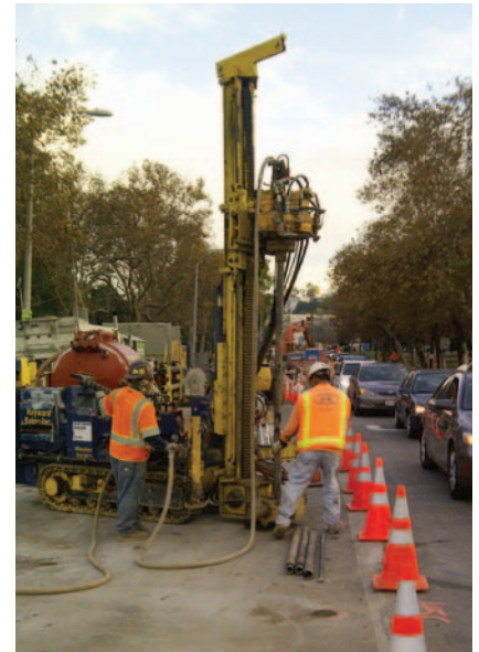
River Supply Conduit Unit 4
